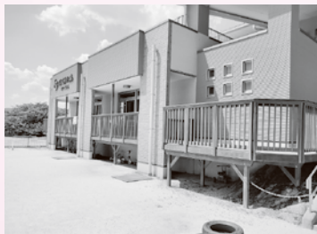
はぐみの森保育園(安全対策整備)
